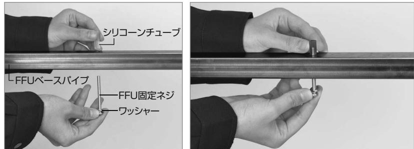
取り付け状態を確認後、右写真のようにFFU固定ネジを一旦沈めておきます。
