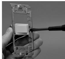
連用枠へ連用器具の取り付け取り外し
